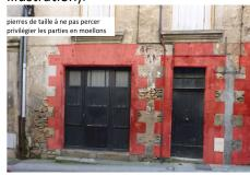
Lorsque la façade ou son rez-dechaussée sont en pierre de taille, les percements seront réalisés dans les joints entre pierres (à l'exclusion des joints dans les arcs ou linteaux appareillés) qui représentent les emplacements le moins impactant pour les pierres.
