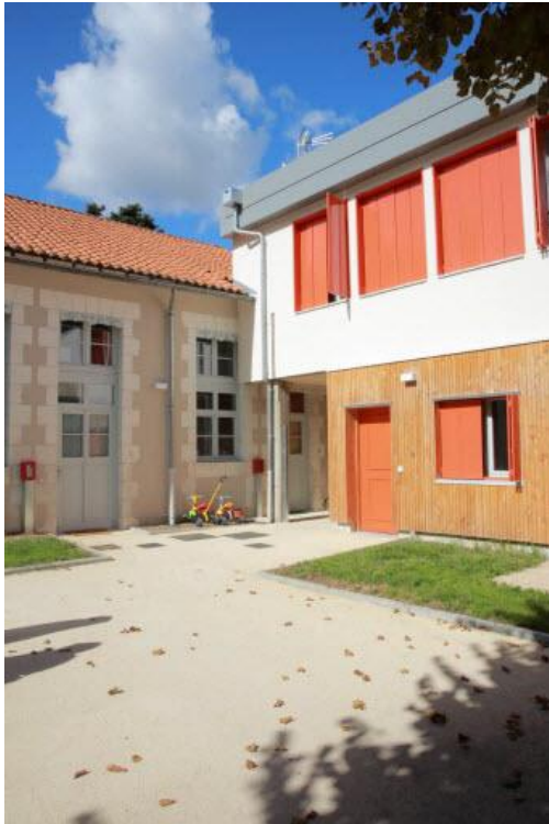
Ecole Saint-Louis réhabilitée en logement social, Poitiers
