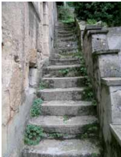
Le chemin en escalier, dit des Meuniers, route de Lessart
