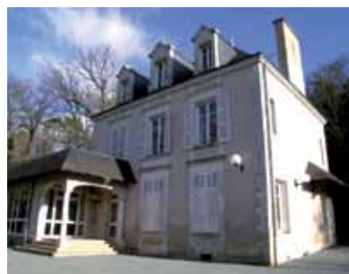
La maison dite « la Bouriquetterie », ancien centre de loisirs de Val-Vert, rue de la Vincenderie
