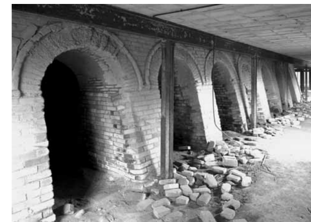
Briqueterie de Ferrière, entrée des tunnels de cuisson
