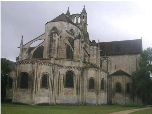
L'EGLISE DE MONTIERNEUF, un chevet roman surélevé d'une partie gothique avec des arcs-boutants
