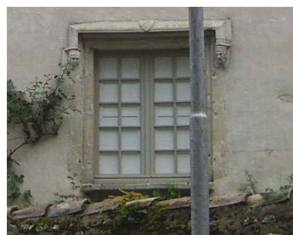
Détail de fenêtres avec traces de meneau sur des constructions du XV e modifiée
