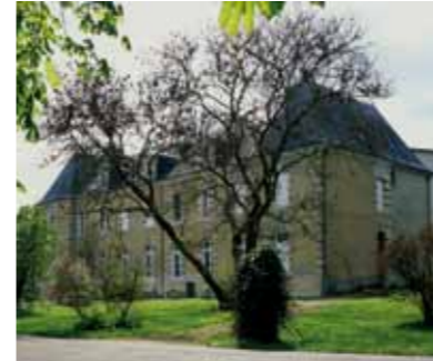
Façade est, ancien bâtiment des jésuites
