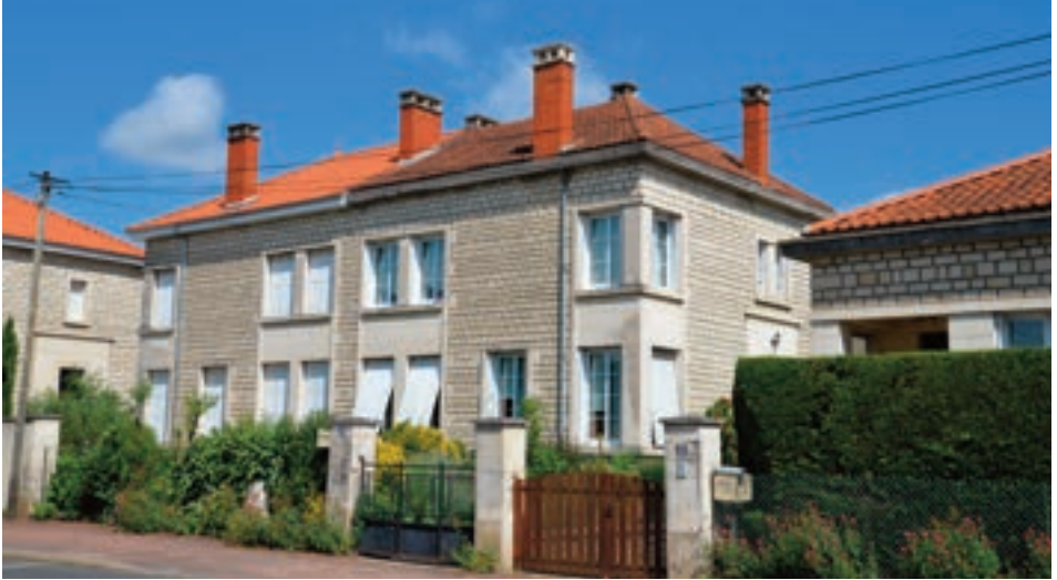
Maisons jumelées des années 1950 situées rue de Poitiers.
