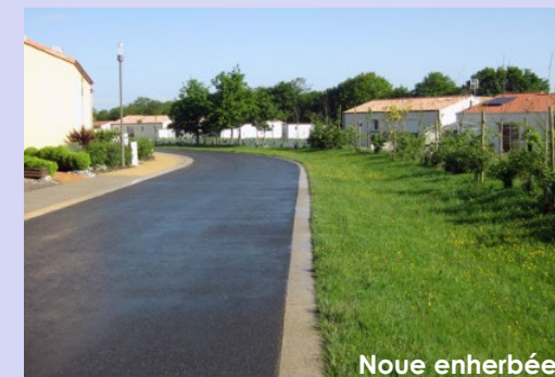
Noue plantée accompagnée d'un chemin
