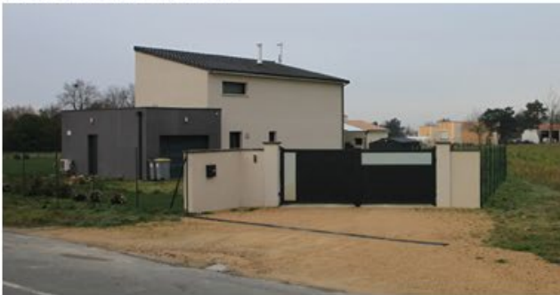
Construction récente apportant un peu de diversité mais délicate à insérer
