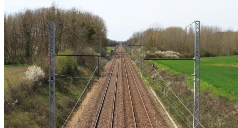
Vue sur la voie ferrée depuis le pont de « Suplice »
