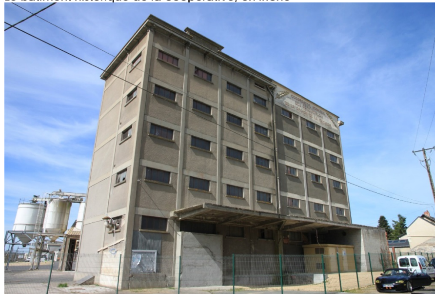
Le bâtiment historique de la coopérative, en friche
