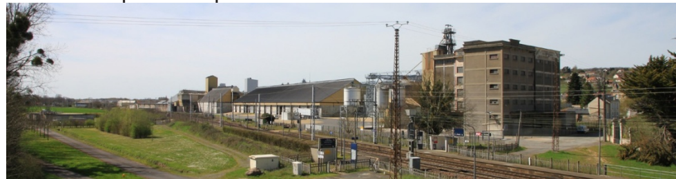
Vue sur la coopérative depuis la RD 82
