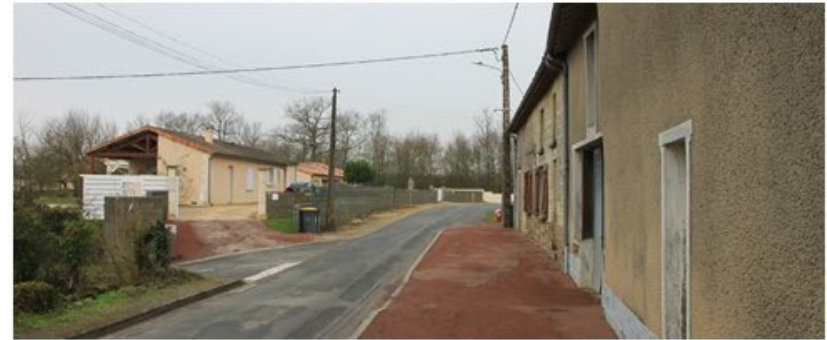
Un rapport à la voie opposé à l'ancien
