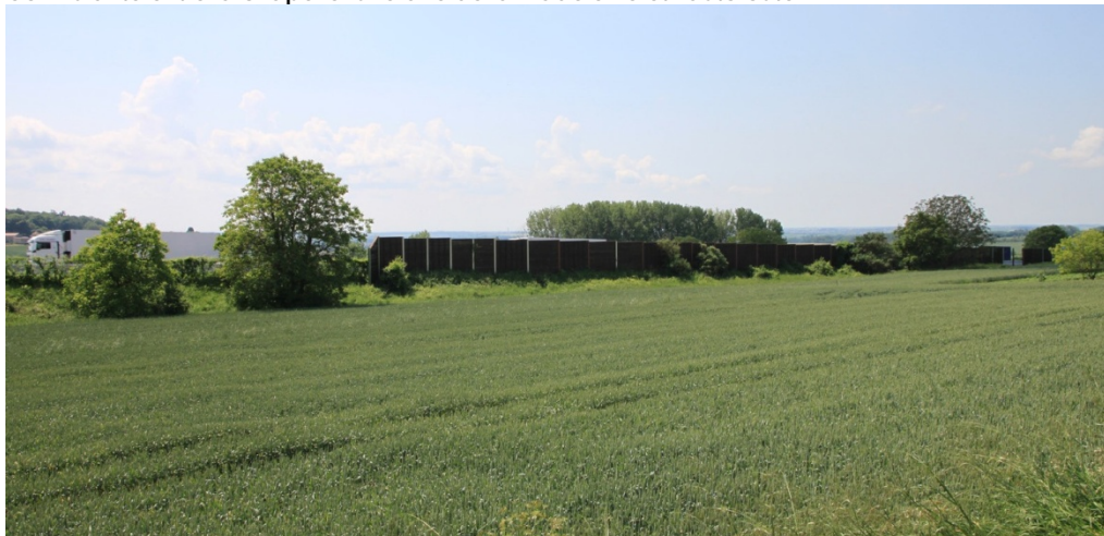
A proximité immédiate de l'autoroute, les vues sont coupées par des panneaux antibruit de couleur sombre qui visent à faciliter leur intégration paysagère
