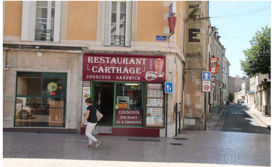
Non-respect des 25 % de surface autorisés - Rue de la Marne
