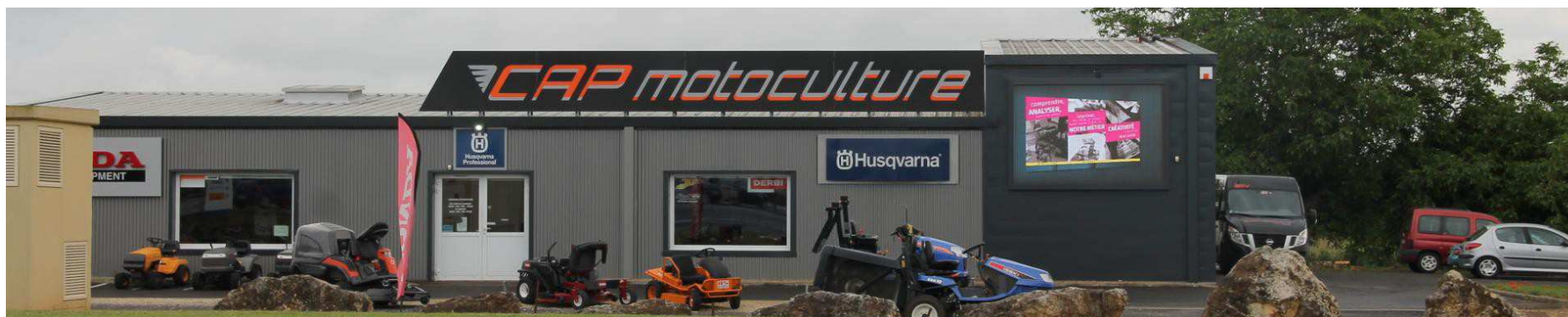
Exemple d'enseigne numérique intégrée à la façade du bâtiment. A noter que l'enseigne sur toiture n'est pas réglementaire – Commune de Jardres
