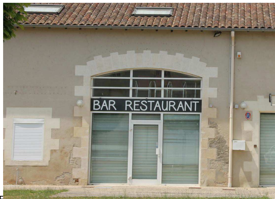
Enseigne murale conforme avec les dispositions nationales Commune de La Chapelle-Moulière
