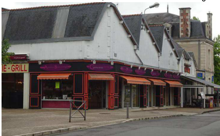
Bien que légale en surface, cette suite de pavés mettant en place un dispositif uniforme et sans relief n'est pas valorisante – Commune de Chauvigny
